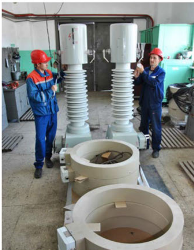
Ремонт масляного выключателя ведут слесарь Сергей Леонтьевич Богданов и механик Максим Александрович Иваненко
