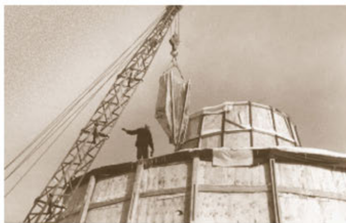
Строительство первой дымовой трубы. 1970-е годы
