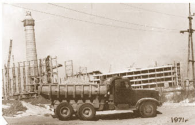
Техника автоколонны № 4 на строительной площадке. 1971 год
