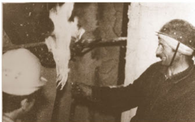
А.П. Рулько, бригадир монтажников «Дальэнергомонтаж», разжигает первый котел станции. 1970-е годы
