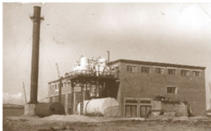
Пусковая котельная. 1970-е годы
