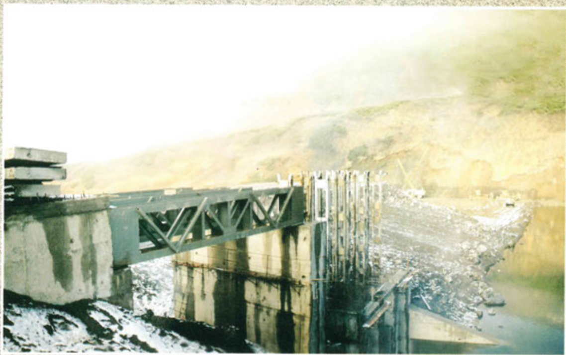
Сооружение плотины ГЭС №1 Толмачевского каскада Фото Л. Негруль
