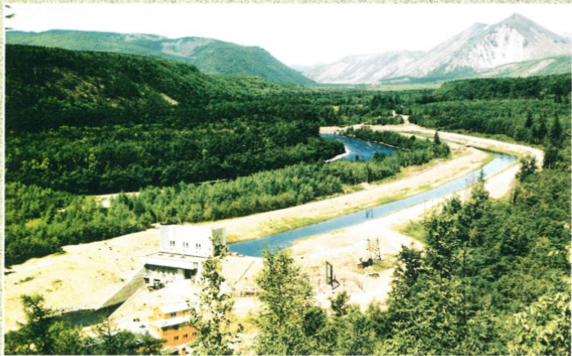
МГЭС-4 на реке Быстрой Быстринского района Фото А. Терещенко
