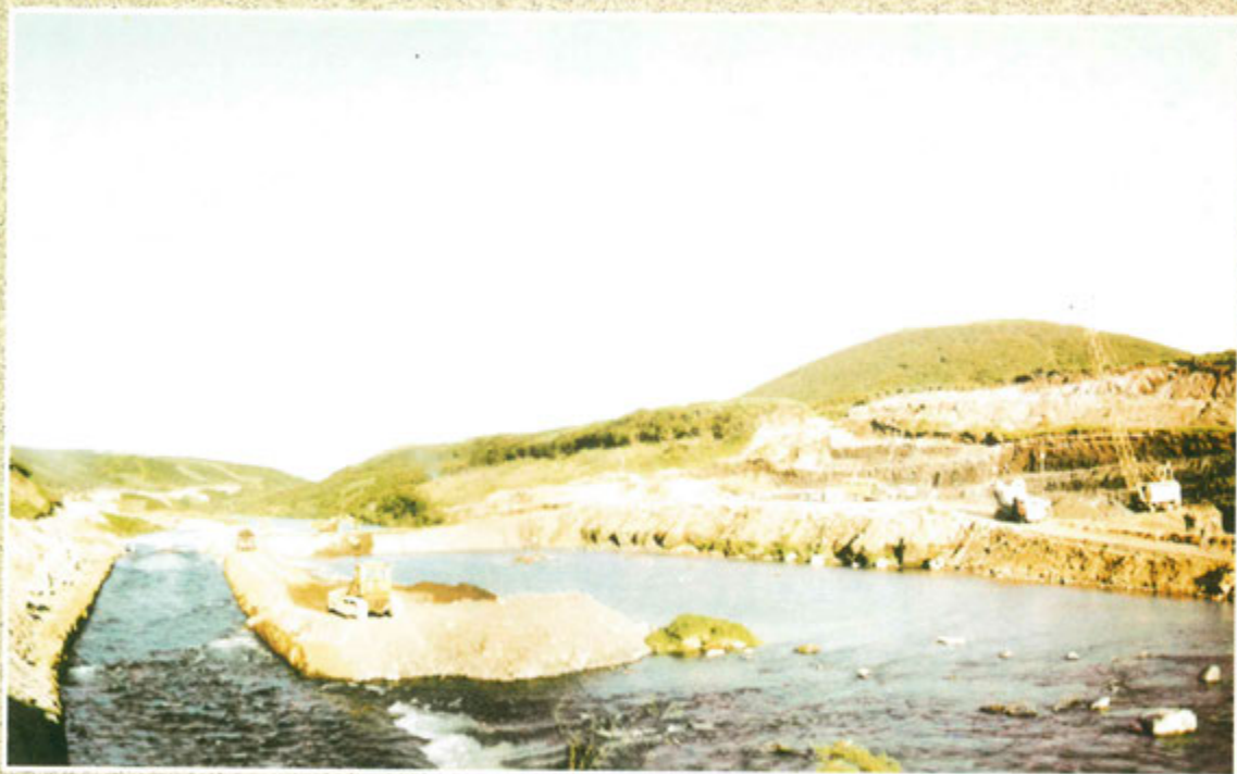
Начало строительства Толмачевской ГЭС Фото Л. Негруль
