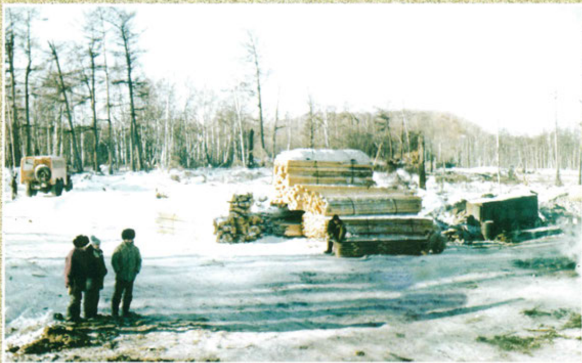
Начало строительства МГЭС-7 на реке Быстрой Быстринского района
