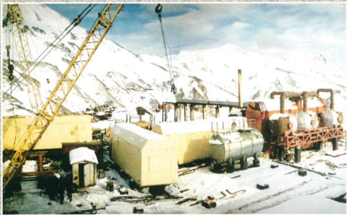
Монтаж оборудования Верхне-Мутновской ГеоЭС
