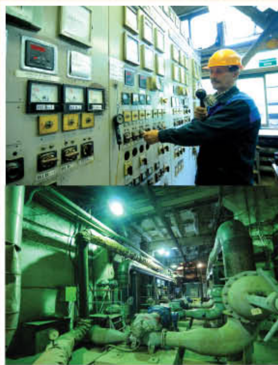
Вид Котельного цеха № 3 внутри
