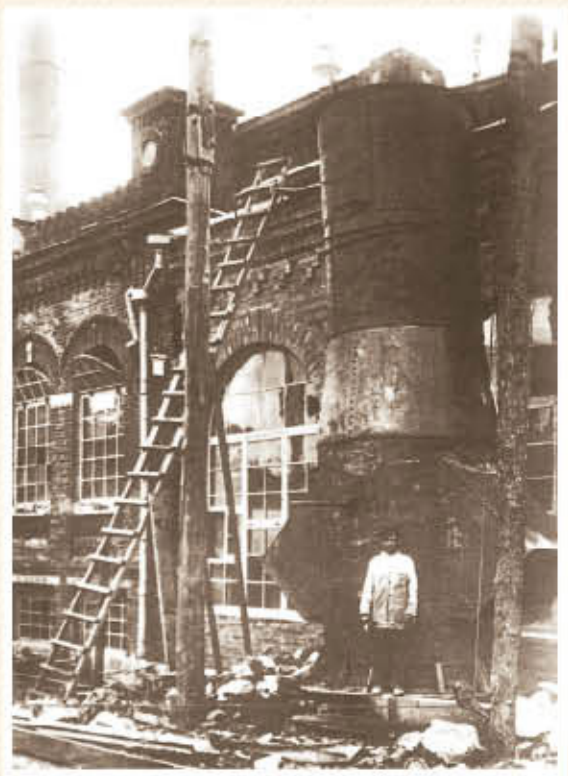
Установка трубы для котла Фицнер и Гемпнер (1927 г)
