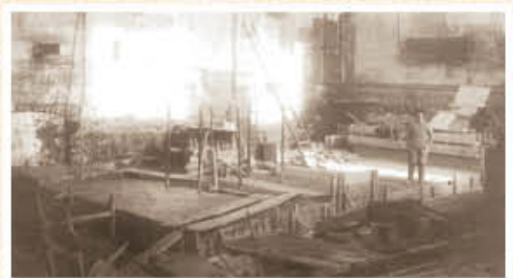
Строительство фундамента для котлов Бобкок-Вилькоккс (1931 г)
