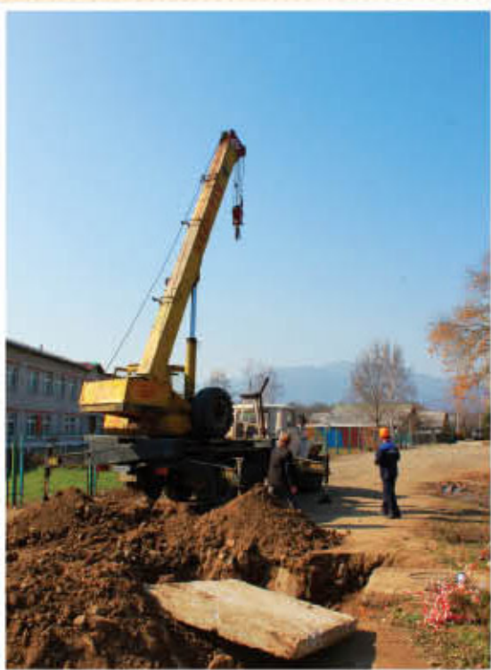
Ремонт теплотрассы в г. Партизанск
