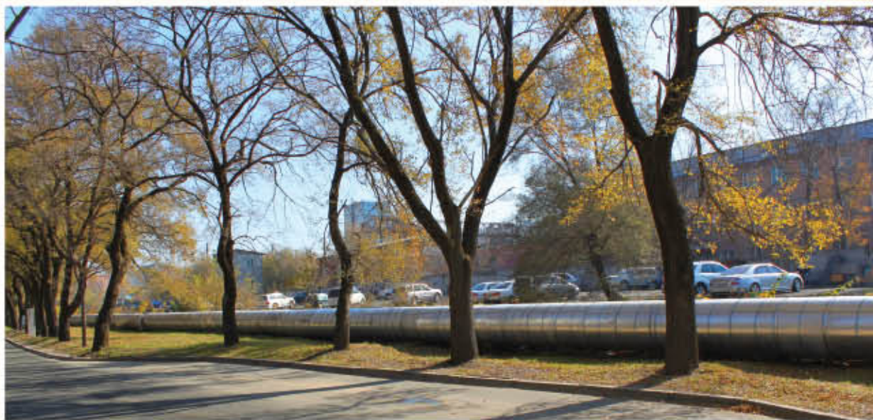
Теплотрасса, ул. Бородинская
