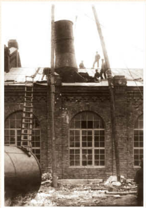
Установка трубы на ВГЭС 1
