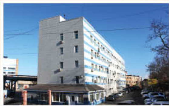
Здание управления филиала «Приморские тепловые сети»
