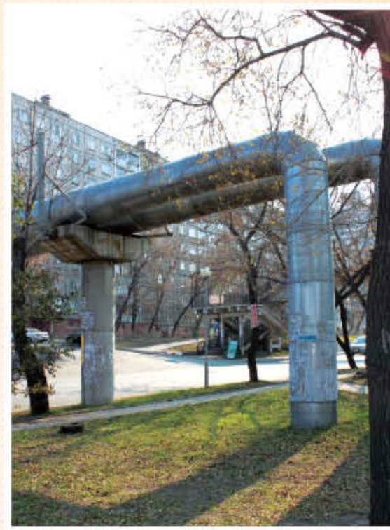
Теплотрасса, ул. Некрасовская
