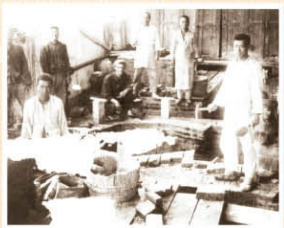
Кладка дымохода котла на ВГЭС 1
