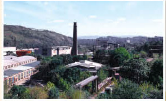
Котельная Снеговая (КЦ-3)
