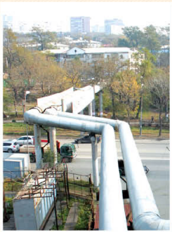
Теплотрасса, ул. Луговая
