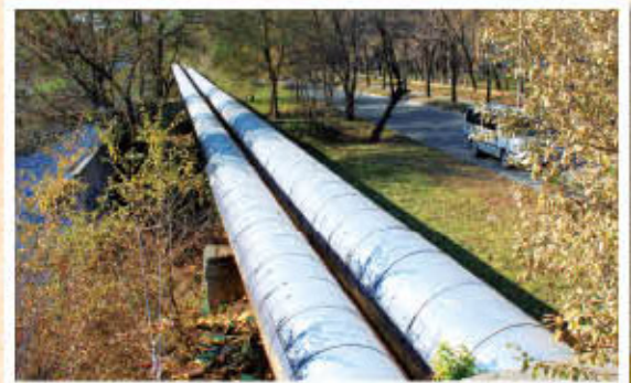
Теплотрасса, ул. Бородинская
