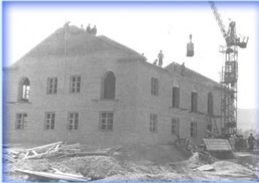
Строительство жилого дома. 1953
