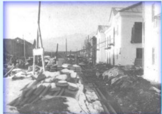
Монтаж теплотрассы п. Лозовый
