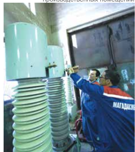
К.В. Васильев и С.М. Кетов - электрослесари по ремонту оборудования РУ 1РЭС
