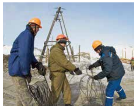
Бригада линейщиков на объекте
