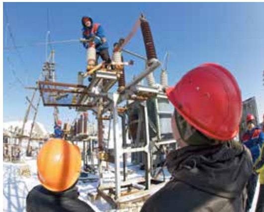
Работа по замене изоляции на ПС «Нексикан»
