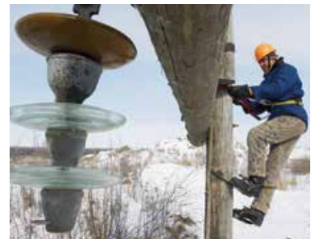
В.Г. Никонов, эл.монтер, ремонт линии
