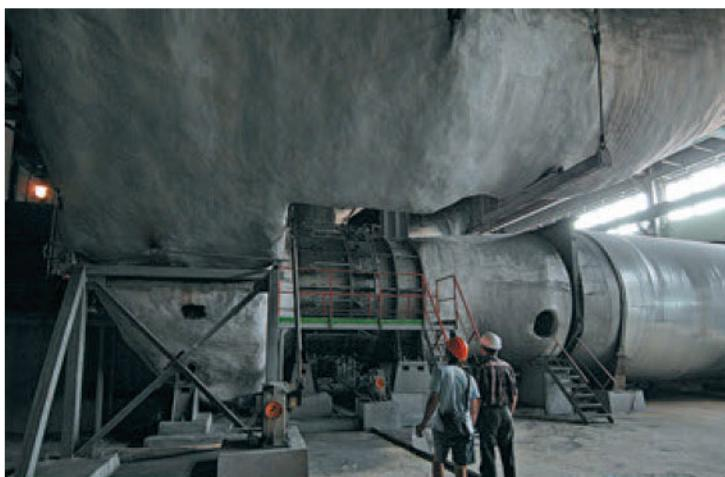
Эти огромные трубы — дымоходы. По ним дым из котла попадает в фильтры очистки, а оттуда — в трубу
