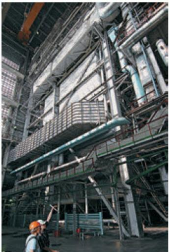
Котел — грандиозное сооружение. Его верхняя точка находится на высоте 54 метров. Причем вся эта громадина подвешена на специальных железобетонных опорах. В целях безопасности и меньшей потери тепла котел обмуровывают специальной штукатуркой. Но все равно воздух вокруг работающего котла достигает порой 45 °С
