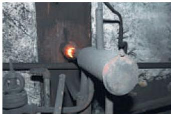
Форсунки — небольшие сопла, через которые воздушно-угольная смесь подается в топку котла. Таких форсунок в котле 16 штук, и для каждой в стенке котла существует свое отверстие
