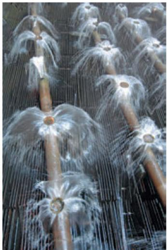
Нагретая паром в конденсаторе вода поступает в градирню и на высоте 8 метров разбрызгивается такими вот фонтанами. Кстати, вода, циркулирующая в системе охлаждения ТЭЦ, так и называется — циркуляционной, или, как принято говорить среди энергетиков, циркводой
