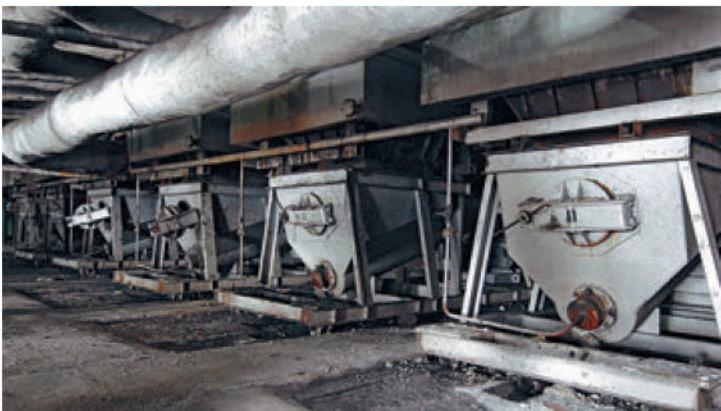
Поскольку котел висит на железобетонных опорах, под него можно заглянуть. А заглянув, можно увидеть так называемые шлакосборники — небольшие металлические контейнеры, в которые опадают несгоревшие в топке котла зола и куски сплавленного шлака. Отсюда они направляются на золоотвал
