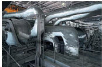
На высоте 54 метров котел заканчивается паровым барабаном — длинным металлическим цилиндром в обмуровке. Часть трубок, которые вы видите, подают горячий пар из котла в барабан, часть — возвращают пар в котел на перегрев
