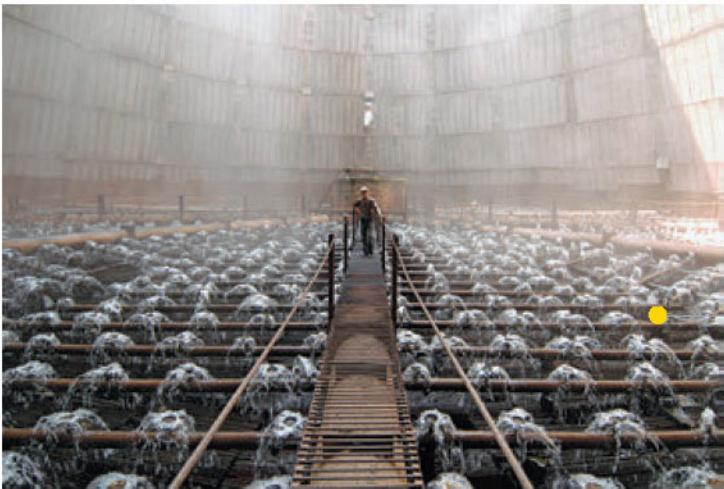
льющая с потолка, остывает в полете до 30 °C (а зимой и до 20 °C), скапливается в бассейне градирни, откуда насосами подается обратно в конденсатор. Необходимость быстро остужать воду диктует большой диаметр основания градирни. Ведь чем больше площадь основания, тем большее количество фонтанов можно на ней разместить. А высота и конструкция трубы создает в ней естественную тягу воздуха, которая уносит вверх остаточный пар и позволяет воде быстрее остывать до нужной температуры.
