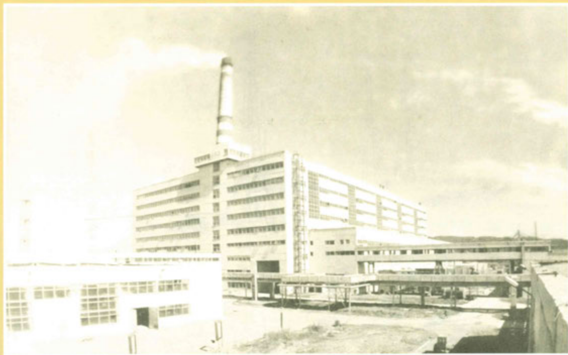
Камчатская ТЭЦ-2. г. Петропавловск-Камчатский
