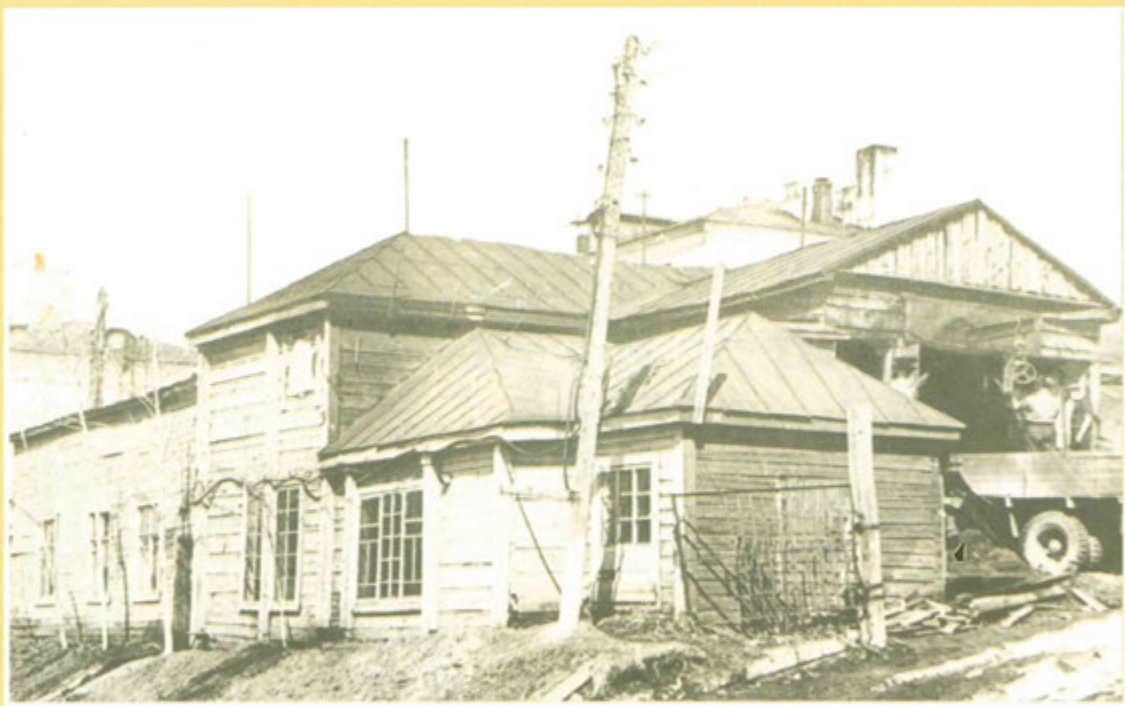
Городская дизельная электростанция по ул. Советской. 1964 г.
