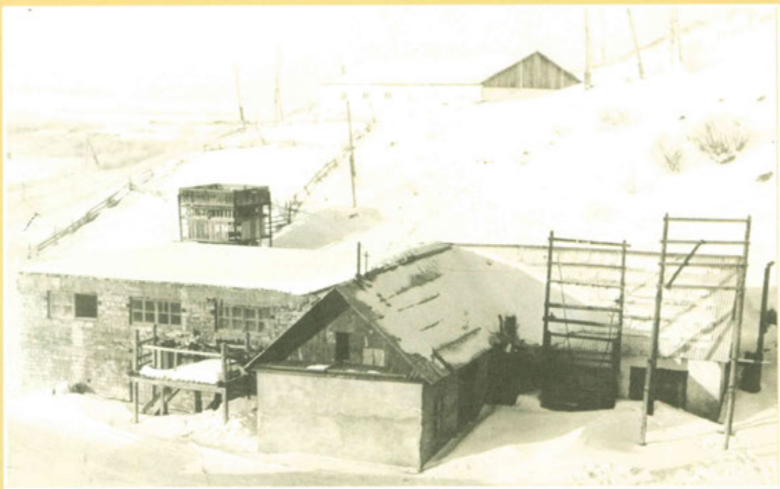
Дизельная электростанция в п. Палана. 1964 г.
