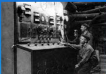
Щит управления котельной установки котла № 1-2 1936 г.
