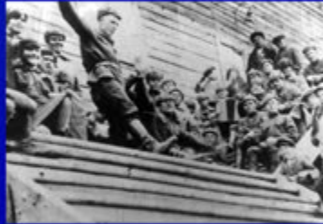
На строительство АртемГРЭС прибыли стройбатовцы Апрель 1934 г.
