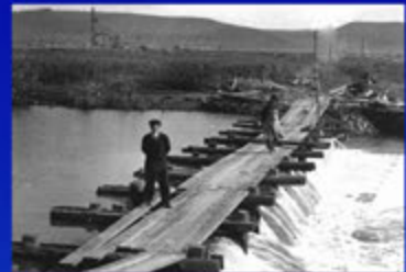
Нижняя перемычка временной водонасосной 1937 г.
