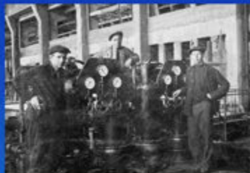
Монтаж первой турбины 1936 г
