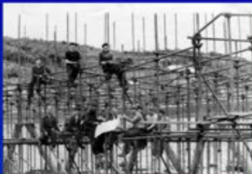
Строительство главного корпуса 1934 г.
