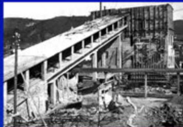
Строительство углеподачи 1936 г.
