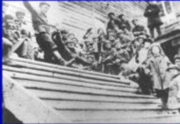
38-й строительный батальон прибыл на строительство ГРЭС 1934 г.
