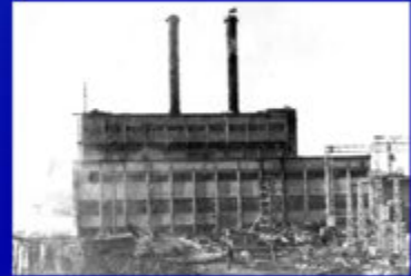
Главный корпус АртемГРЭС 1936 г.
