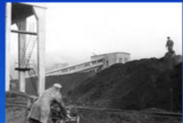
Топливо-транспортный цех Угольный склад 1936 г.
