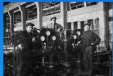
Монтаж первой турбины 1936 г.
