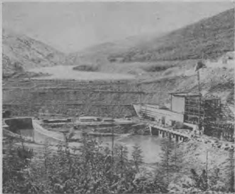
Первенец гидроэнергетики Северо-Востока — Колымская ГЭС строится и расширяется
